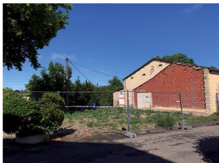
Le chantier de la rénovation de la halle a été lancé, courant mai, avec le lot désamiantage. La prochaine étape consistera à remplacer la pierre de taille sur le pilier avant les travaux sur la partie sanitaires.
